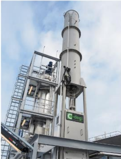
Die neue Methanisierungsanlage mit der Fackel im Vordergrund und dem Turm, in dem sich der Bioreaktor befindet.
